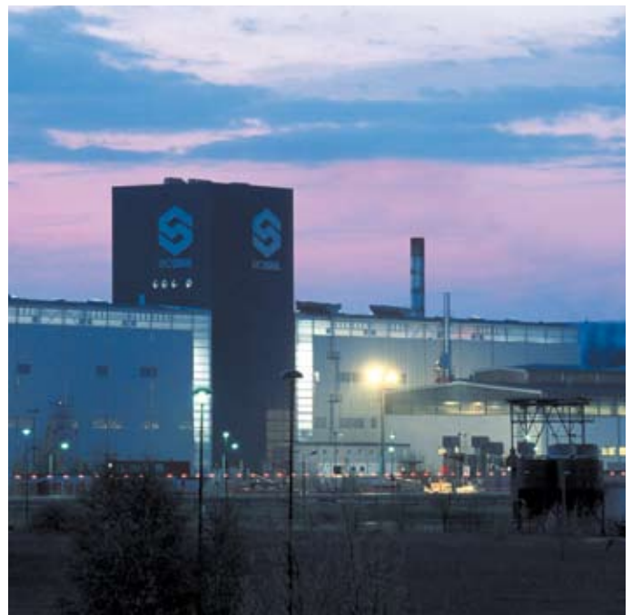
EKO Stahlwerk GmbH, Eisenhüttenstadt
